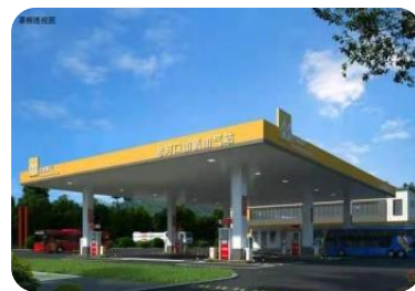
襄阳老河口加氢站
